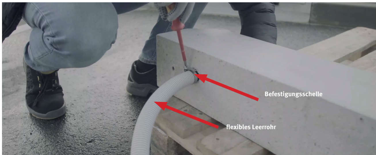
Abb. 9: Leerrohre anschließen
