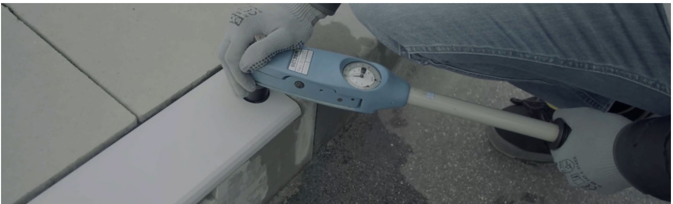
Abb. 19: Schutzdeckel ausrichten und Sicherheitsschrauben festziehen
