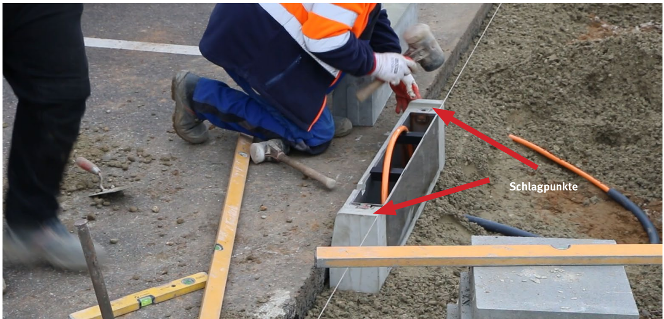
Abb. 14: Schlagpunkte Bordsteinverbau
