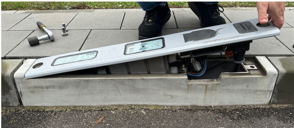
Abb. 41: Elektronikmodul in den Bordstein ablassen
