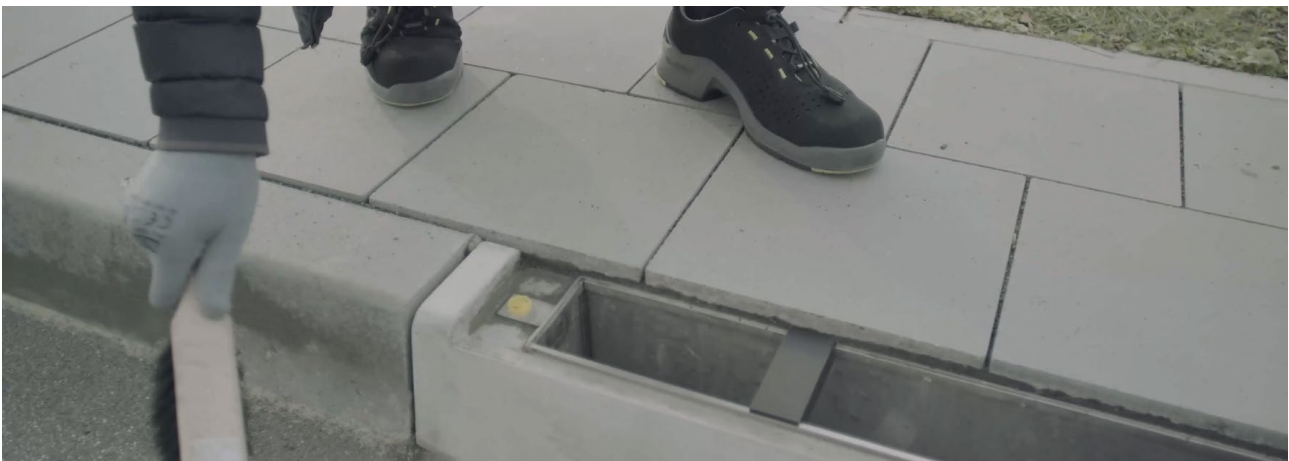
Abb. 12: Mitgelieferten Gewindeschutz beidseitig prüfen
