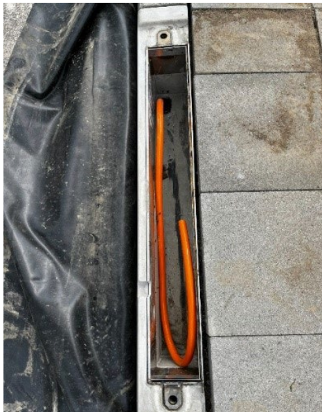
Abb. 23: Verbauter Bordstein mit Anschlussleitung – Länge 1 m
