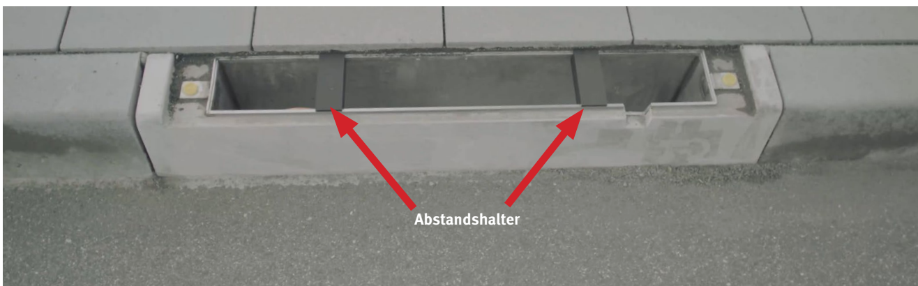
Abb. 13: Eingebaute Abstandshalter (entweder aus Holz oder Kunststoff)
