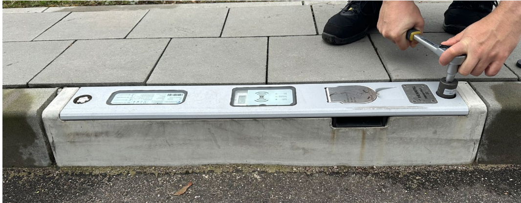
Abb. 42: Verbautes Modul fixieren
