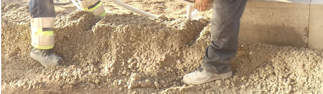
Abb. 11: Zwei Aussparungen im Fundament
